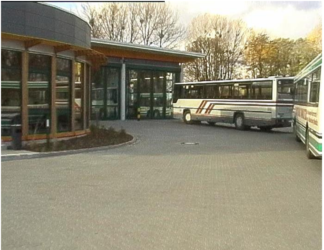
BUSBETRIEBSHOF der Barnimer Busgesellschaft mbH in Bernau bei Berlin
